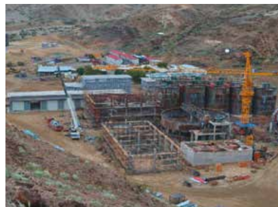
Foto 2: Baustelle Tagebau Koka
